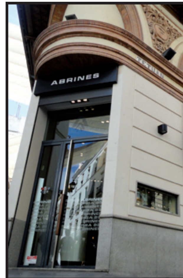
Fachada del establecimiento de la calle Tetuán.
